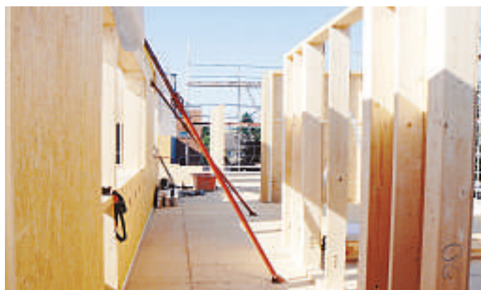
A Diemeringen, la technique de construction à ossature bois permet un avancement très rapide du chantier. (Photo DNA - A.L.)
